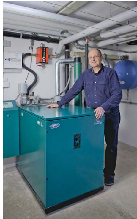
WKK-Präsident Heini Glauser vor seinem eigenen Mini-BHKW in Windisch. Er darf neu den Strom auch seinem Nachbarn liefern (Doppeleinfamilienhaus).
