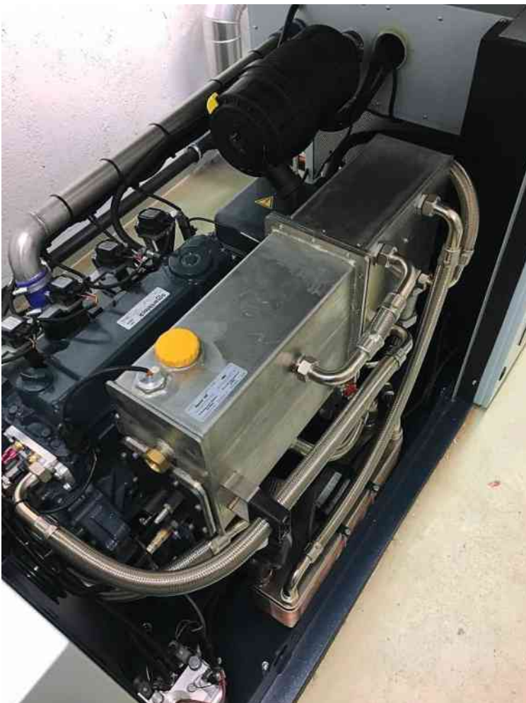
Innenansicht smartblock-BHKW.
