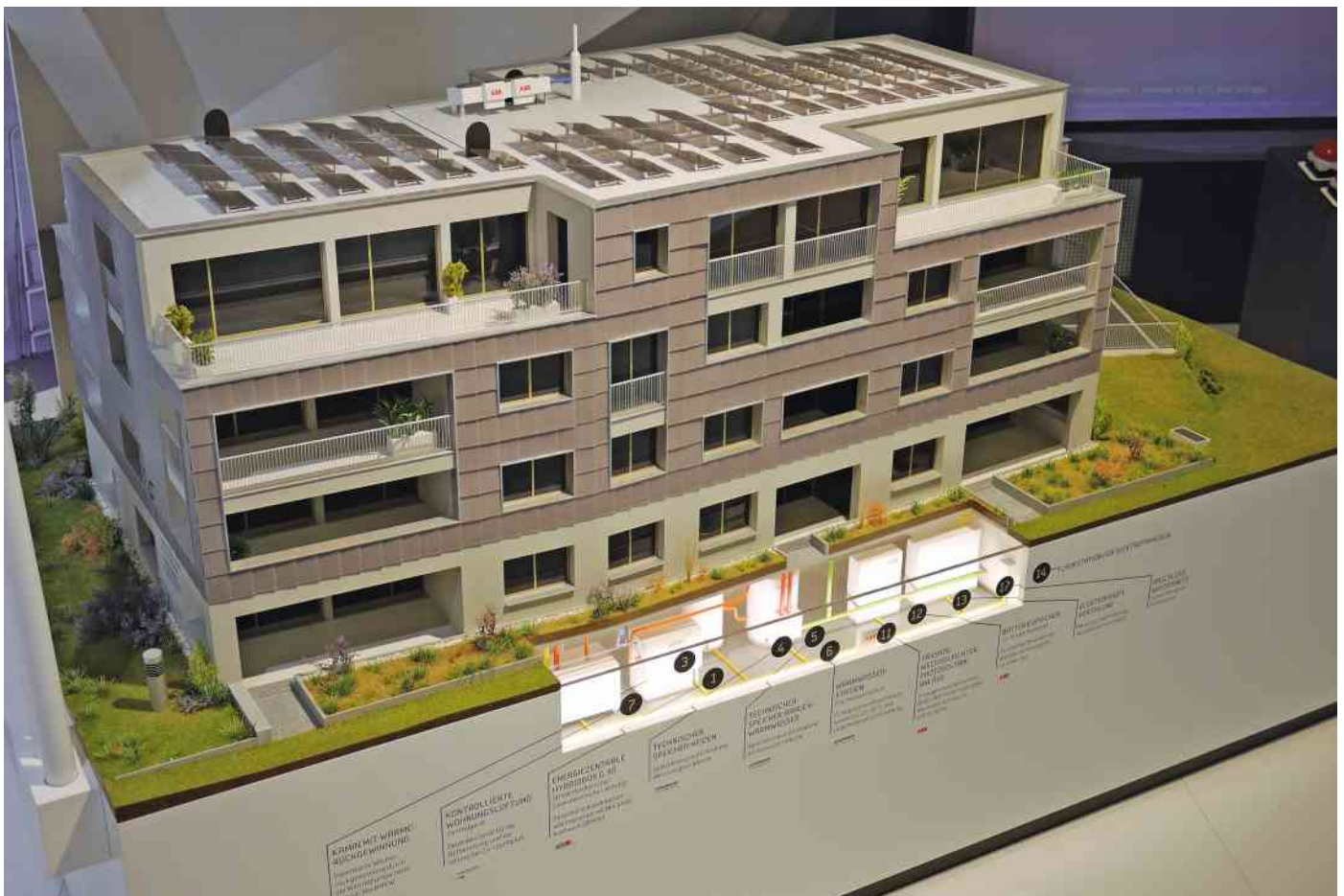
Das Modell in der Umwelt Arena zeigt u. a. folgende Gebäudetechnik-Komponenten: PV-Anlagen auf Dach und an Fassaden, kontrollierte Wohnungslüftung, Energiezentrale mit Hybridbox, technische Speicher für Heizung und Trinkwarmwasser, Ladestationen für Elektrofahrzeuge etc.
