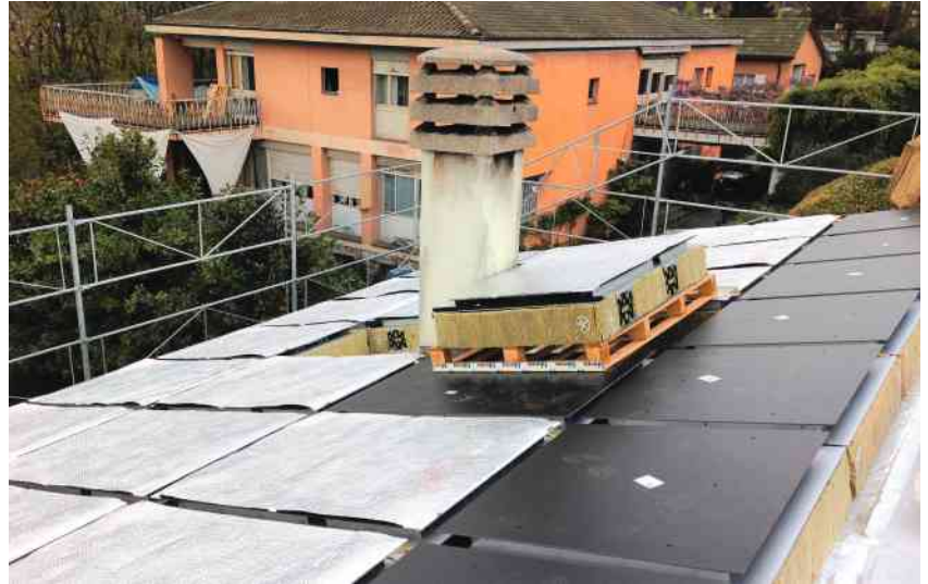
Die TCR-Dachelemente bestehen hauptsächlich aus einer Wärmedämmung und den PV-Modulen. Diese sind hier für die Montagephase teilweise noch mit einer silbernen Schutzfolie abgedeckt. (Fotos: Designery)
