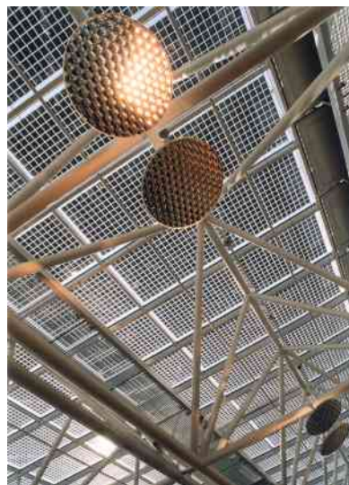
In Isolierglas integrierte PV-Zellen, welche der Migros Genossenschaftsbund im Jahr 2000 an seinem Hauptsitz am Limmatplatz in Zürich realisiert hat. (Foto: energiebüro ag)
