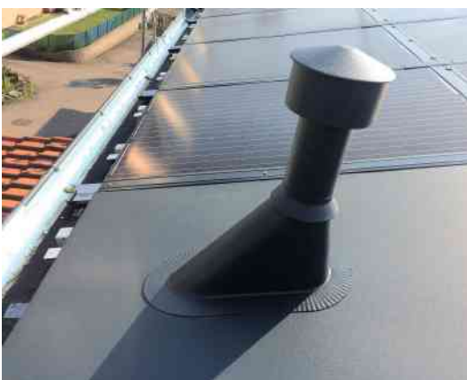
Wo Aufbauten die Belegung mit PV-Modulen verhindern, werden passive Flächen eingebaut und in einem späteren Schritt mit der Spenglerei abgeschlossen.
