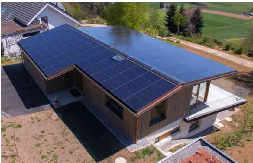
Das Einfamilienhaus in Gerzensee produziert über 6 x mehr Strom als es verbraucht.
