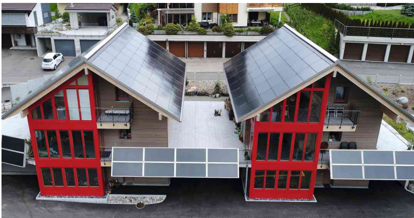
237%-PEB-MFH in Oberiberg SZ, Südansicht: Die nach Ost-West ausgerichtete PV-Anlage erzeugt jährlich 46 300 kWh. Die 60° geneigten 36 m 2 Solarkollektoren liefern 12 900 kWh pro Jahr und sorgen im Winter für eine optimale Warmwasserversorgung.
