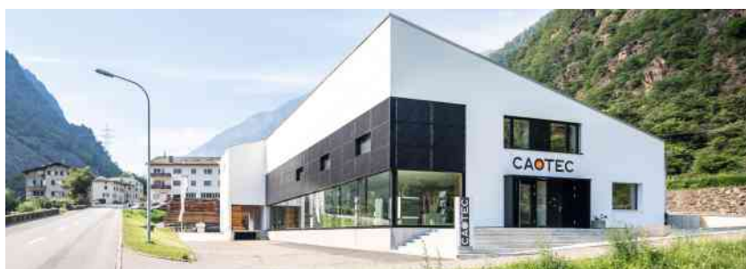
Das renovierte Firmengebäude der Caotec-Haustechnik, Brusio.
