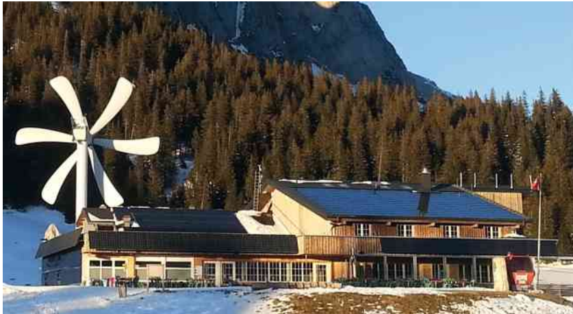
Verschiedene Technologien stellen den Energiebedarf im Berggasthaus Gamplüt weitgehend sicher.
