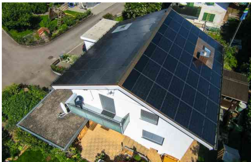
125%-PEB-Sanierung EFH in Uetendorf BE.
