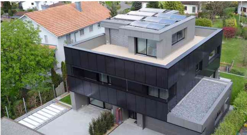
Einfamilienhaus in Würenlos mit kostengünstiger, fassadenintegrierter PV-Anlage.
