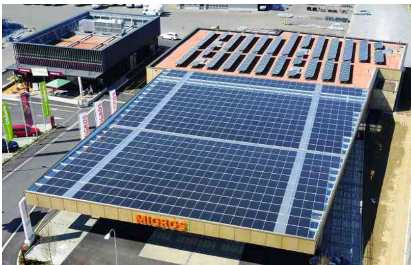
Die Migros-Filiale Amriswil mit der dachintegrierten PV-Anlage (vorn) und der aufgeständerten Anlage (hinten).
