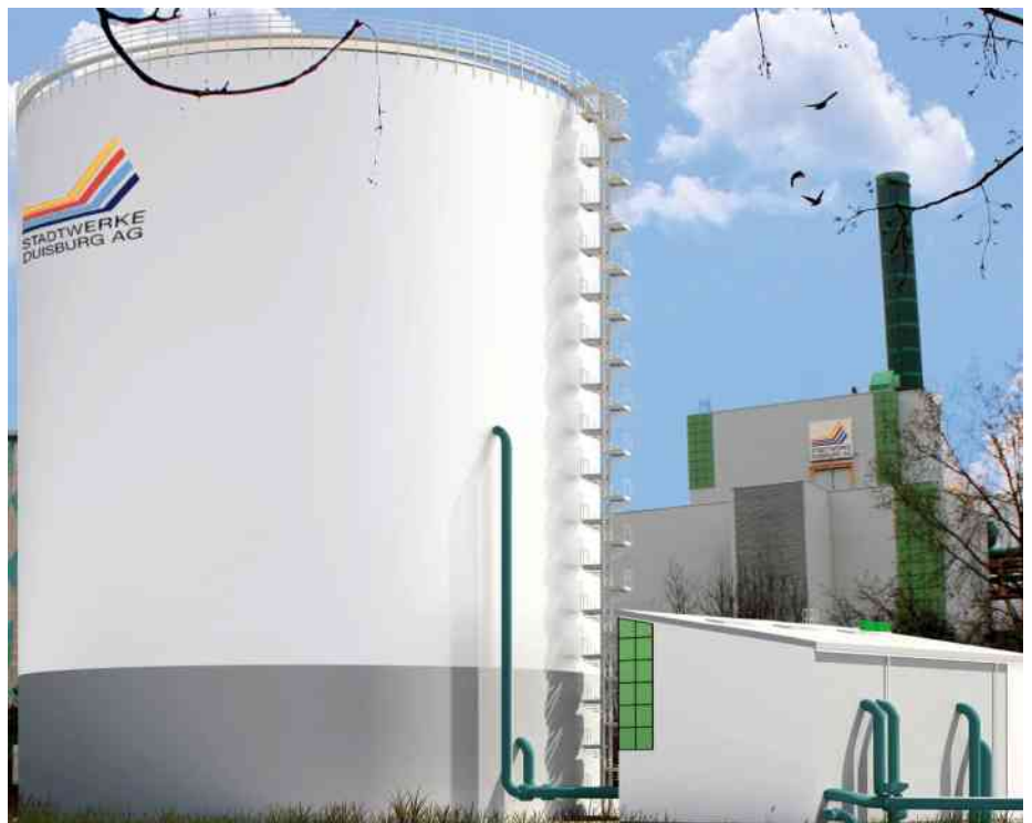
Pufferspeicher ermöglichen eine gezielte Lastverschiebung bei der Wärmeversorgung und so einen konstanteren Grundlastbetrieb. (Bild: Bilfinger VAM Anlagentechnik GmbH)
