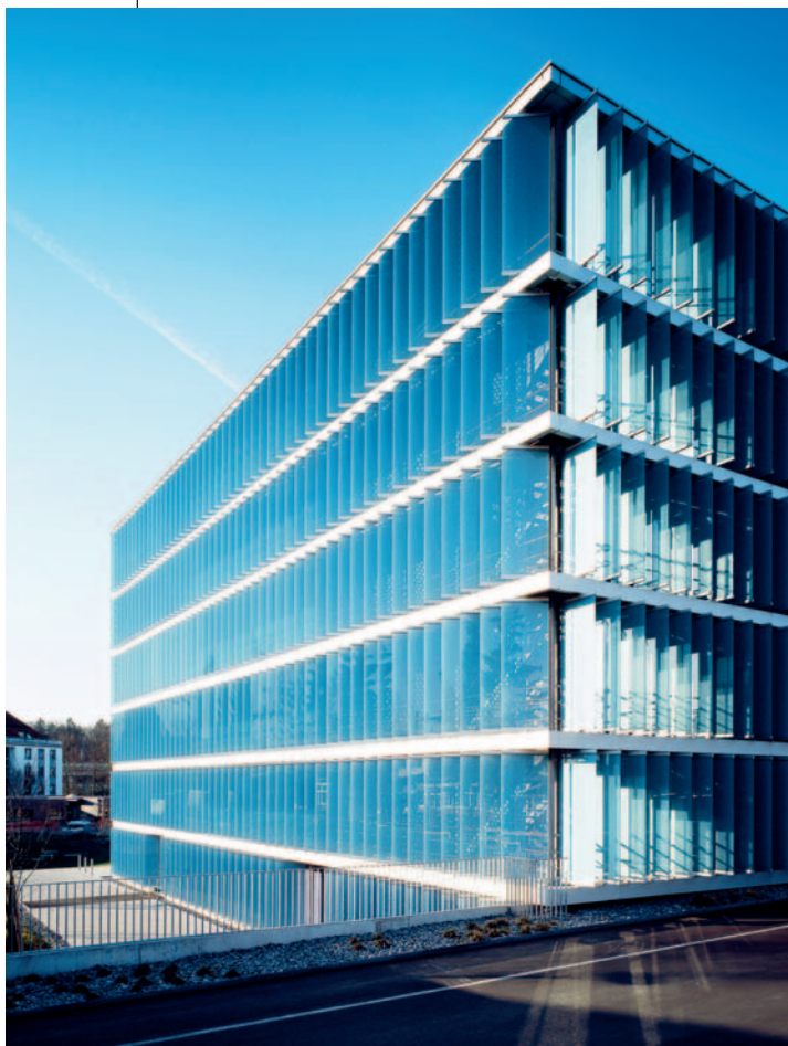
Eawag Forum Chriesbach: Die siebbebedruckten Glaslamellen werden dem Sonnenstand nachgeführt. (Foto: Roger Frei)
