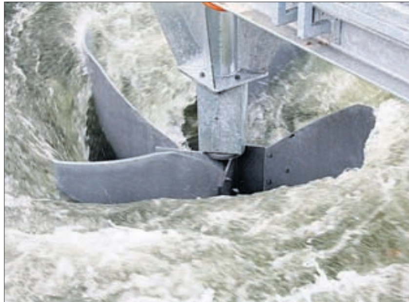
NEUHEIT Erstes Wasserwirbelkraftwerk ist in Schöffland erfolgreich in Betrieb. HO
